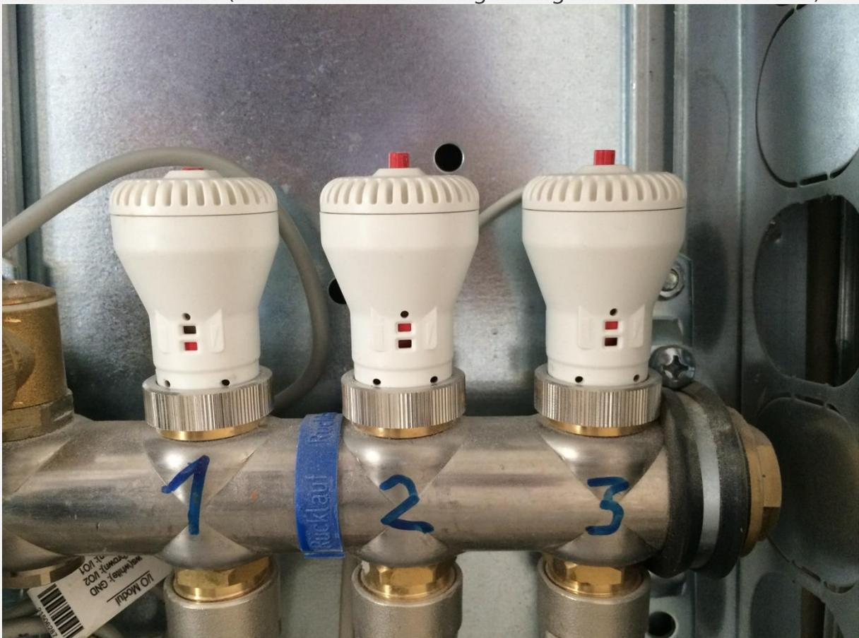
Abb. 3 – Durchflussanzeiger (2 Mitte und 3 rechts zeigen Durchfluss an)
